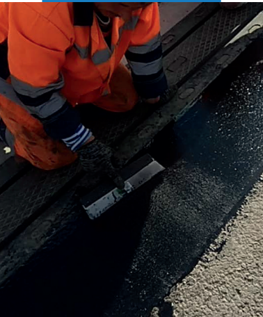
Укладка Polymer concrete PU65 (Полимербетон ПУ65) в пришовной зоне деформационного шва
